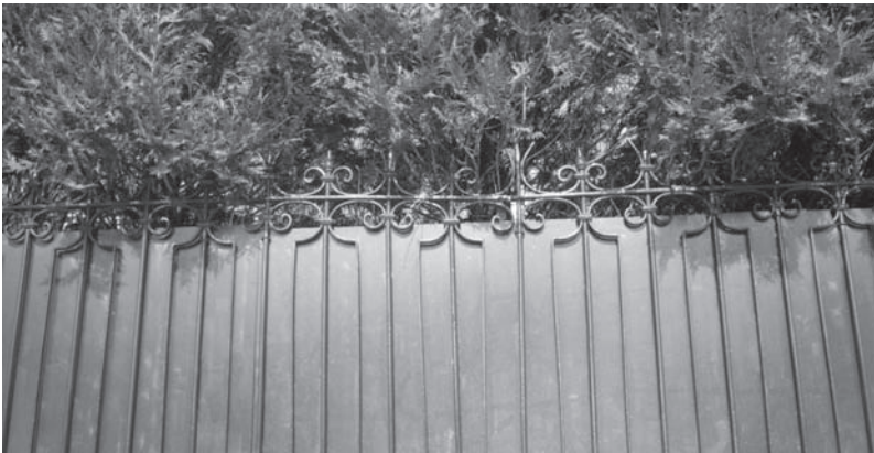
Figura 3. El muro opaco y fácilmente franqueable posibilita al allanador no ser visto desde el exterior.
