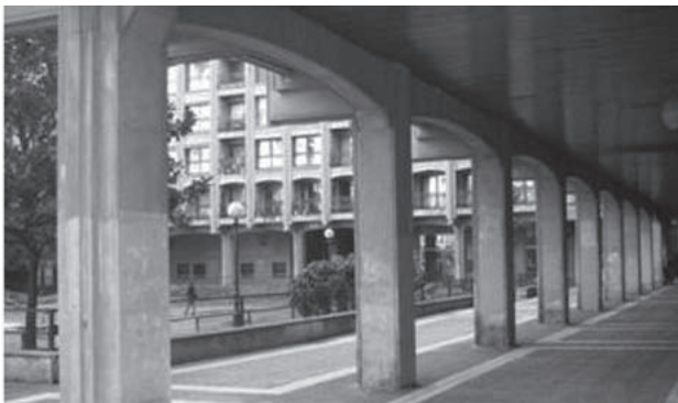
Figura 6. El asaltante puede observar sin ser visto.
